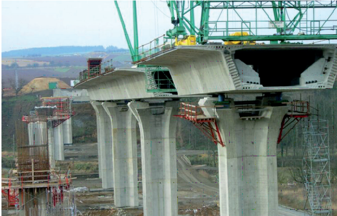
Rys. 3.2. Most skrzynkowy
