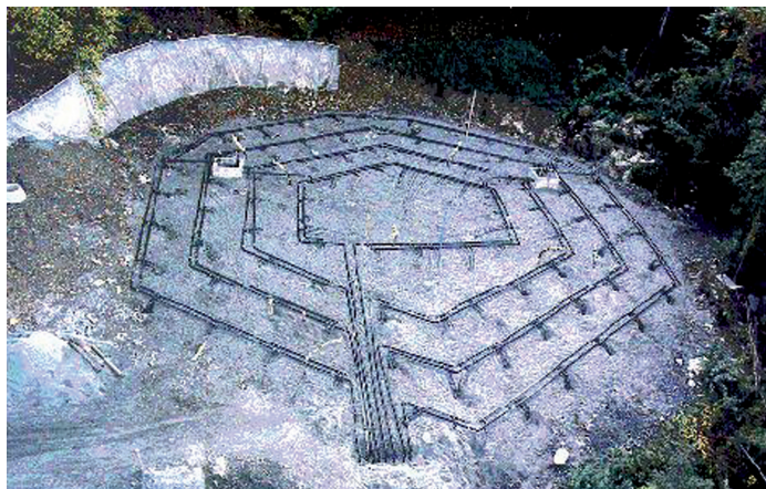
Rys. 2.7. Widok połączonych gruntowych wymienników ciepła
