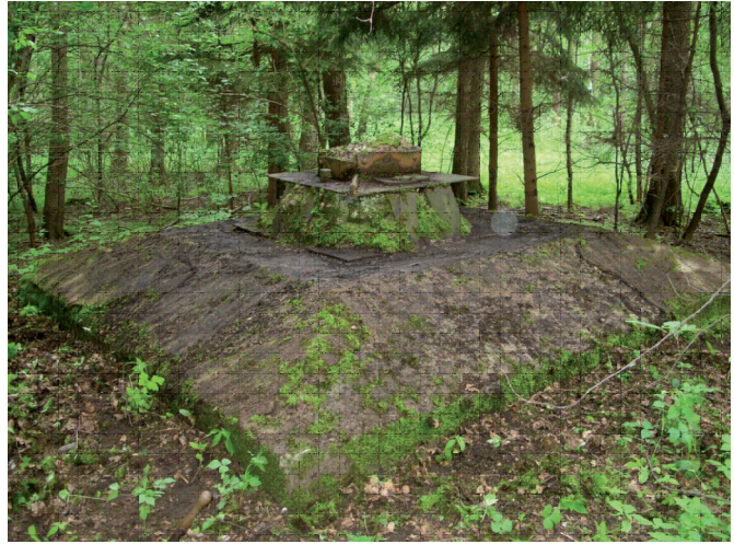
Ryc. 5. Stalowo-betonowy fundament masztu VII. Górna część betonowa nie zachowała się, co umożliwia obserwację szczegółów konstrukcji wewnętrznej. Krawędź podstawy ma 4 m długości
