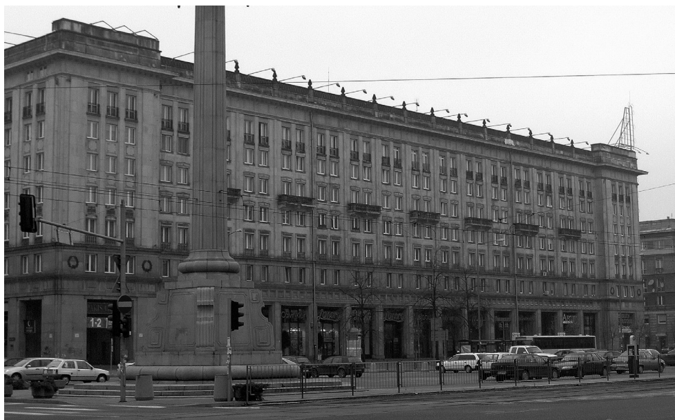
Ryc. 1. Blok przy pl. Konstytucji, widok od strony zachodniej
