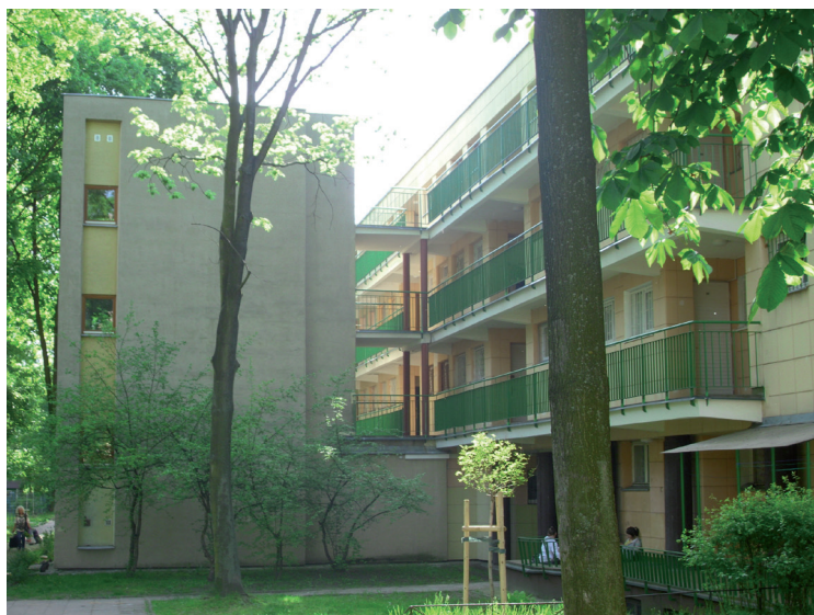
Ryc. 5. Galeriowiec na osiedlu Koło, ul. Deotymy
