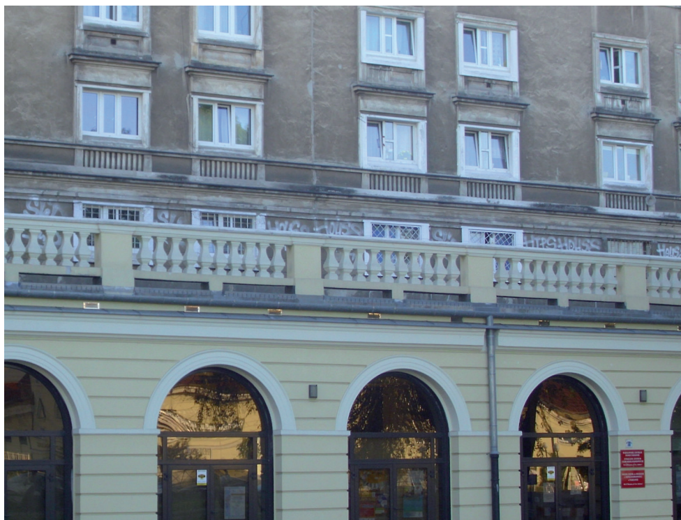
Ryc. 4. Muranów, blok przy ul. Gen. Andersa, róg al. Solidarności
