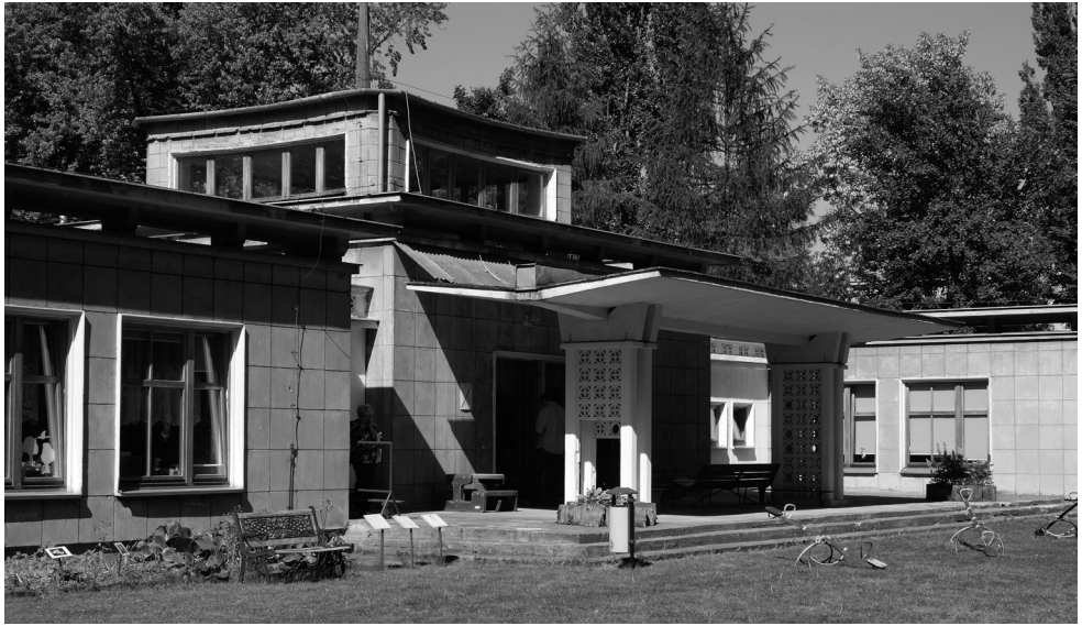
Ryc. 7. Przedszkole nr 135 przy ul. Ringelbluma. Widok od strony ul. Czorszyńskiej
