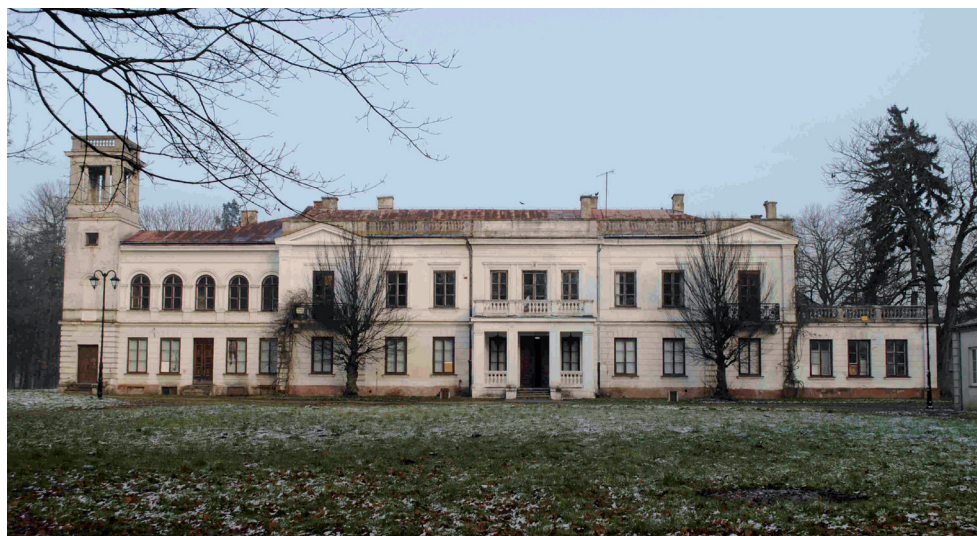
Ryc. 3. Pałac w Sannikach, elewacja frontowa, stan przed rozpoczęciem prac
