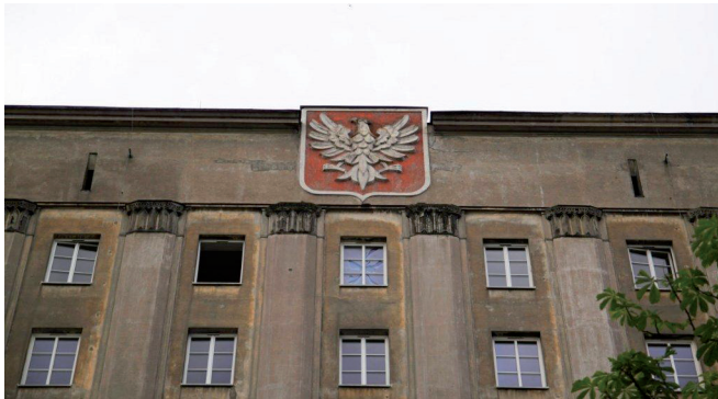
Ryc. 15. Gmach „Akademika” – zwieńczenie elewacji frontowej; godło (orzeł bez korony) umieszczone po 1945 r.
