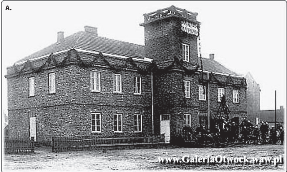
Ryc. 7. Remiza strażacka: A. lata 30. XX wieku, widok na elewację południowo-wschodnią; B. obecnie, widok na elewację południowo-wschodnią – widoczna rozbudowa w kierunku południowym i północnym
