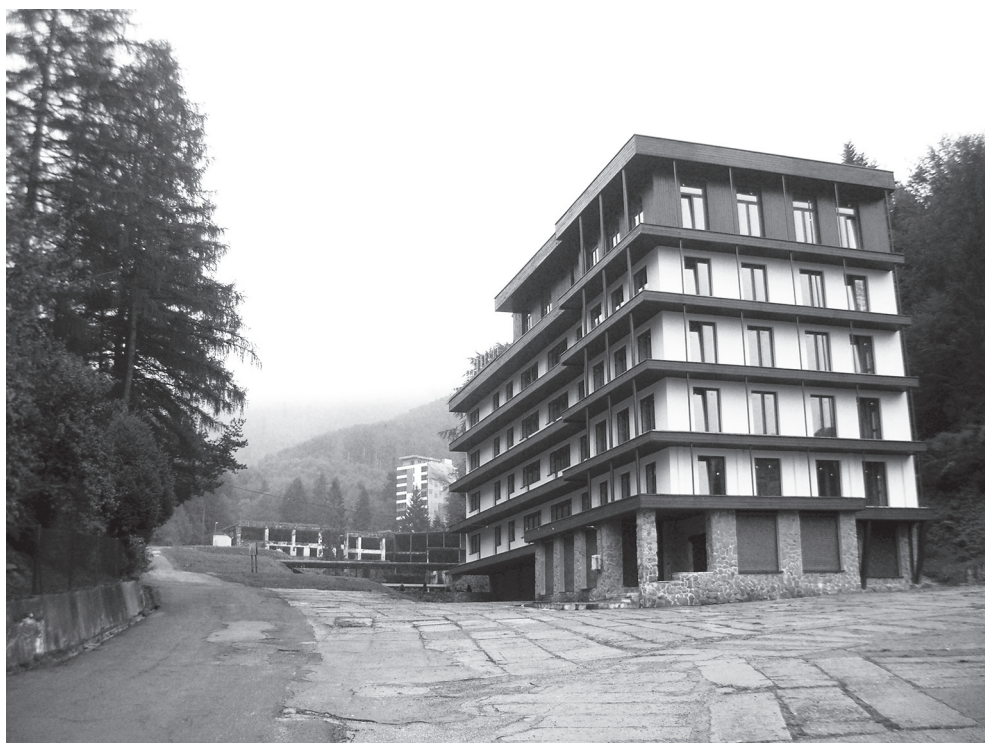
Ryc. 3. Kozubnik-Porąbka, Ośrodek wypoczynkowy Hutniczego Przedsiębiorstwa Remontowego
