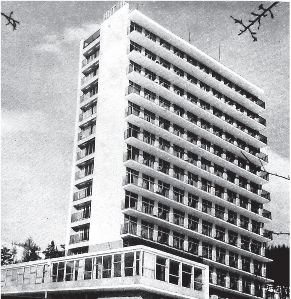
Ryc. 5. Szczawnica, Sanatorium „Hutnik” – architekci: Z. Fedykówna, J. Nowicki
