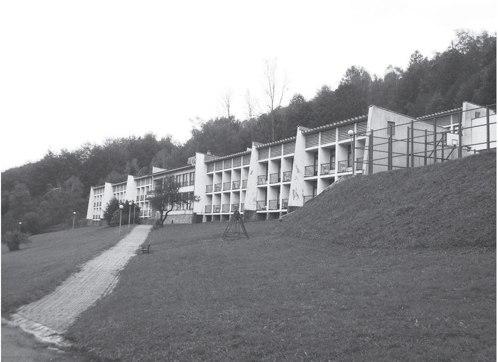
Ryc. 2. Jaszowiec, Dom wczasowy „Jawor” – architekci: C. Kotela, I. Kotela, J. Winnicki, Z. Winnicki
