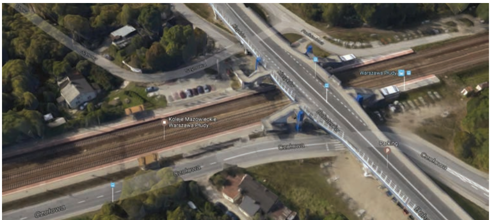
Ryc. 25. Widok na wiadukt drogowy linii kolejowej E65 Warszawa - Gdynia w ciągu ul. Klasyków i ul. Bohaterów w Warszawie – widoczne schody i windy prowadzące z wiaduktu na perony, jako najkrótza możliwa droga dojścia ze stacji do przystanków autobusów miejskich
