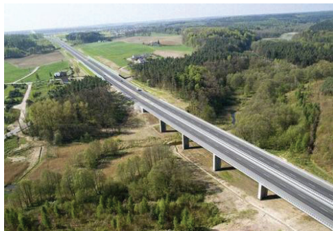
Fot. 4. Przejście dolne dla dużych zwierząt na autostradzie A-1 w Koziarach koło Tczewa
