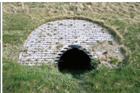
Fot. 6. Przykład przepustu dla małych zwierząt i płazów
