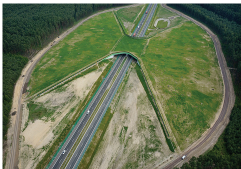
Fot. 3. Przejście górne dla dużych zwierząt na drodze S-3 w Popowie koło Skwierzyny
