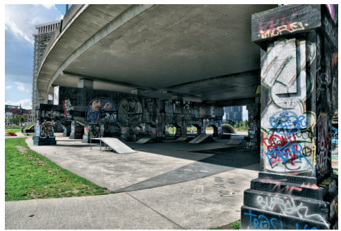
Fot. 7. Przestrzeń rekreacyjna pod wiaduktem drogowym przecinającym park
