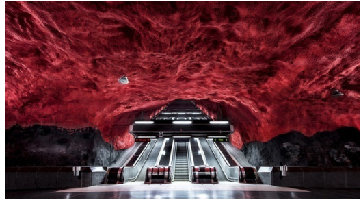
Ryc. 29. Stacja Solna Centrum w Sztokholmie
