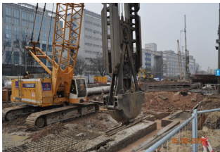
Ryc. 30. Metoda ścian szczelinowych
