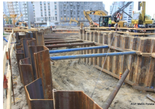
Ryc. 31. Metoda ścianek oporowych Larsena
