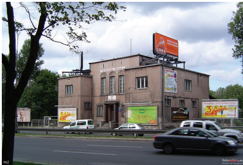
Ryc. 15. Budynek Klubu Sportowego 'Spójnia' przy ulicy Wybrzeże Gdyńskie 2 w Warszawie stan przed 2010, obiekt rozebrany z powodu korekty trasowania Wisłostrady
