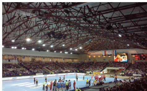
Ryc. 14. Hala Torwar w Warszawie Obiekt wzniesiony w 1953 r., zmodernizowany w 1999 r.
