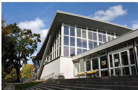
Ryc. 12. Hala gier, widok elewacji zachodniej, AWF Warszawa, proj. W. Zabłocki
