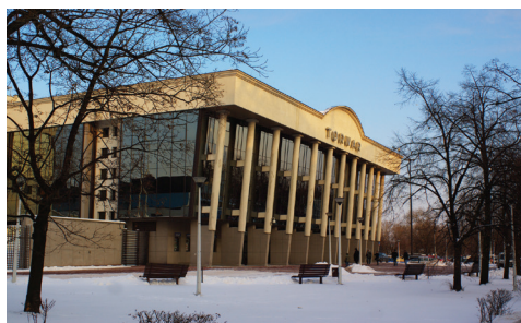
Ryc. 13. Hala Torwar w Warszawie Obiekt wzniesiony w 1953 r., zmodernizowany w 1999 r.
